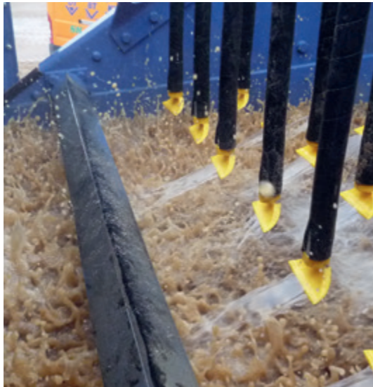
Kurzbebrausung an der Entwässerungssiebmaschine
