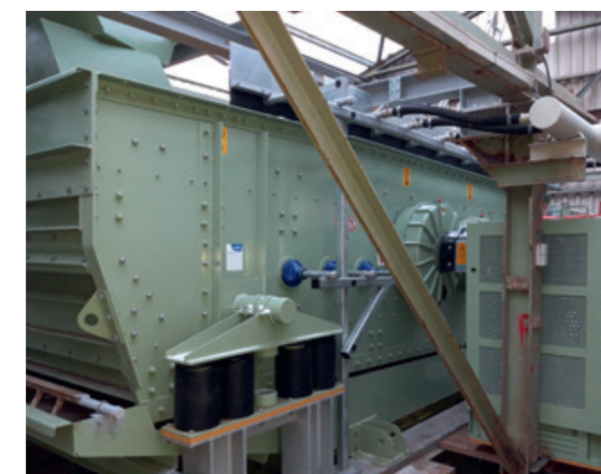
neuer Ellipsenschwinger (2.500 x 6.000 x 2) eingepasst in den vorhandenen Stahlbau
